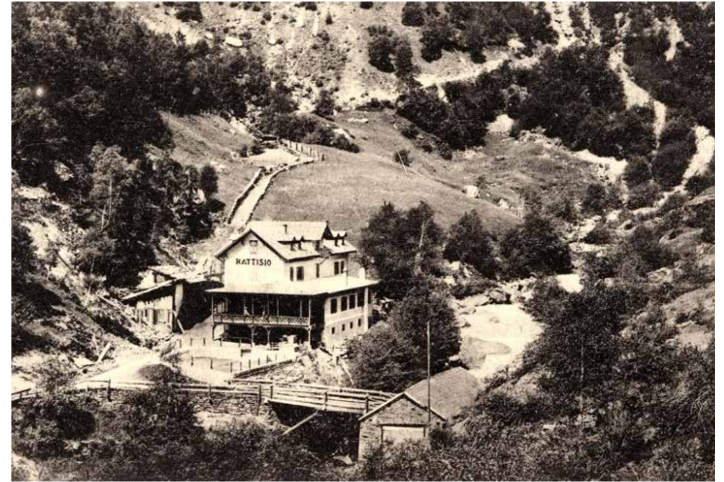
Neuratheis, erbaut 1883; man sieht gut den steilen Aufstieg des alten Talweges, welcher von Fahrzeugen nicht benutzbar war
