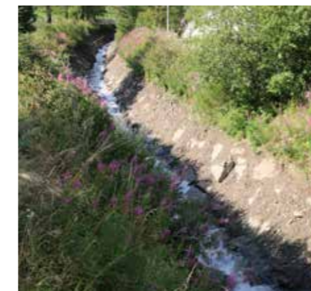
Vernagtmure - Bachbett verbaut
