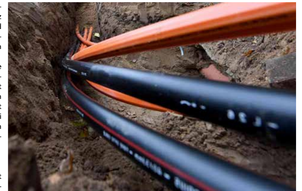
Verlegung der Glasfaserleitung
