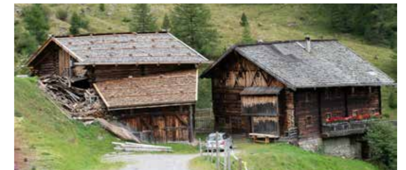
Neues Schindeldach am landwirtschaftlichen Gebäude am Innerkoflhof in Kurzras
